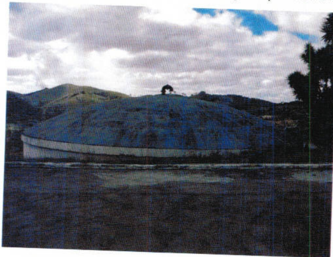
Figura 19: Vista do Principal Reservatório de 1500 m 3 de Guararema, localizado na área da ETA – Sede.
