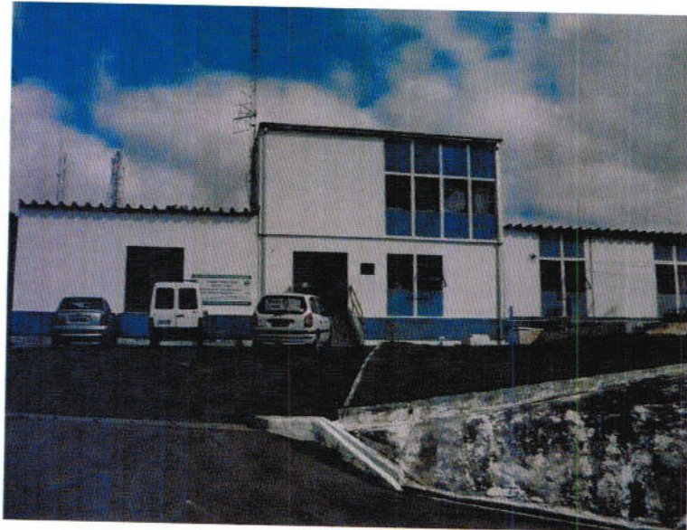
Figura 13: Vista Geral da Estação de Tratamento de Água - ETA – Sede.
