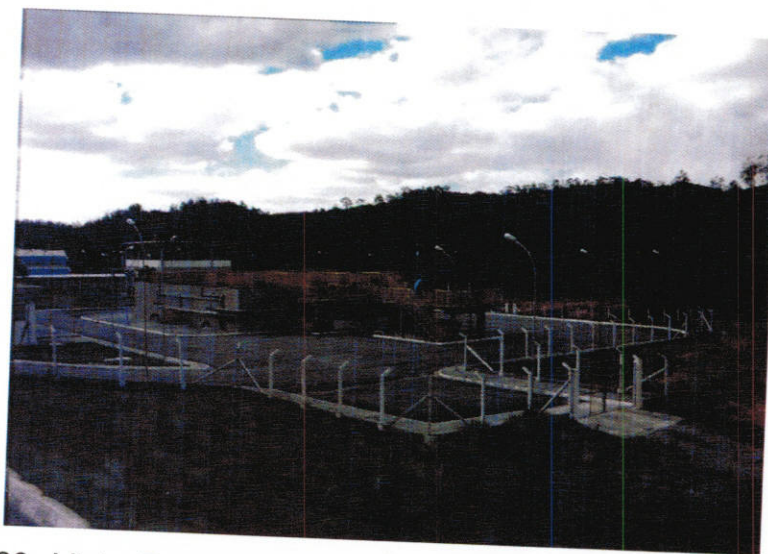
Figura 20: Vista Panorâmica da Estação de Tratamento de Esgotos de Guararema.
