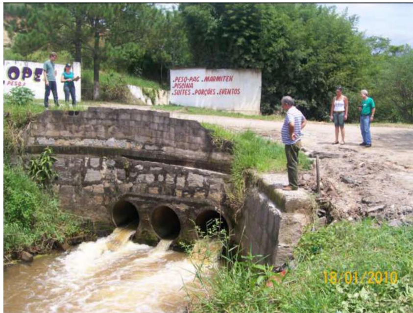
Foto 59 – Vista parcial dos tubos tomada a jusante
