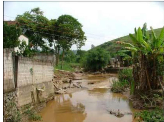
Figura 10 – Ocupação irregular e danos estruturais
