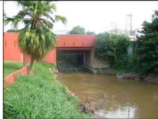
Figura 22 – Passagem sob a Rua 19 de Setembro
