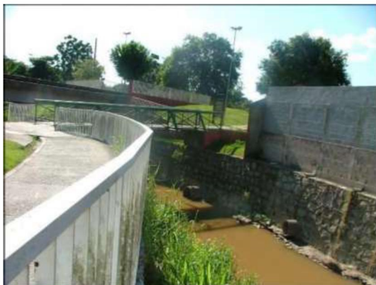
Figura 15 – Passarela de pedestres
