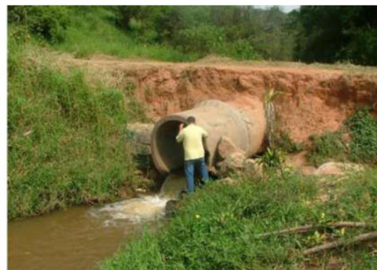
Figura 30 – Saída da tubulação
