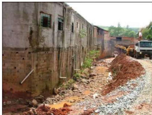
Figura 36 Canal de Montante
