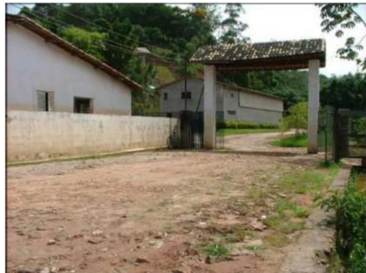
Figura 44: Ocupação de APP e mancha da enchente.
