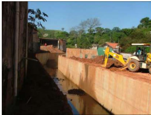
Firura 38 – Canal de concreto
