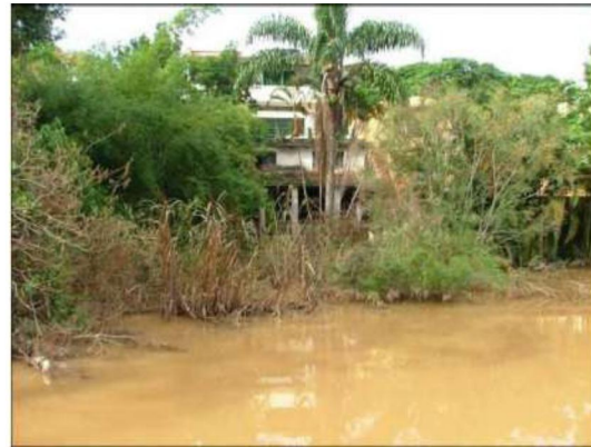
Figura 8 – Canal a jusante da Creche.
