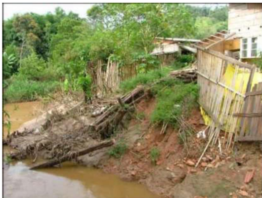
Figura 11 – Erosão de margem e assoreamento
