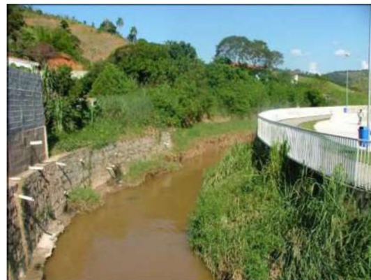
Figura 16 – Canal a montante da passarela
