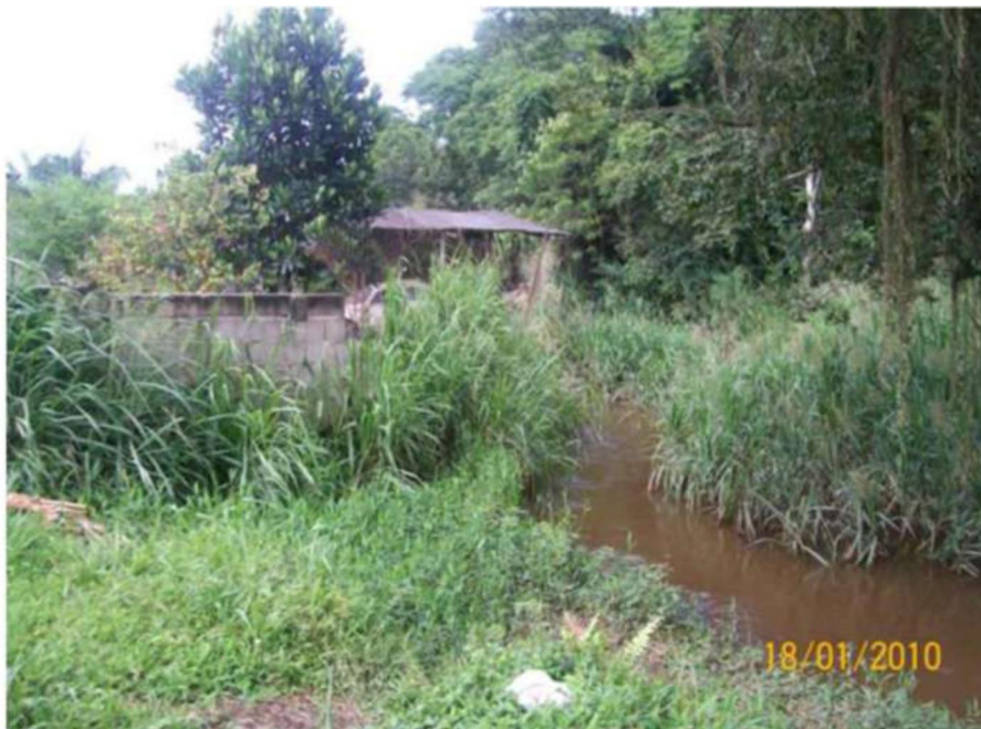
Foto 54 – Ocupação irregular da margem do ribeirão Putim
