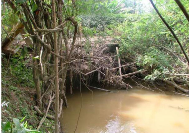
Figura 31 – Passagem do Ribeirão Guararema sob a Estr. Mun. Romeu Tanganelli
