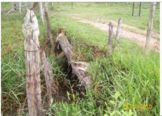
Figura 51 - Passagem sob a estrada.
