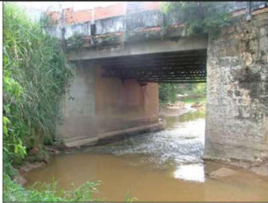
Figura 21 – Passagem sob a Rua Francisco Freire
