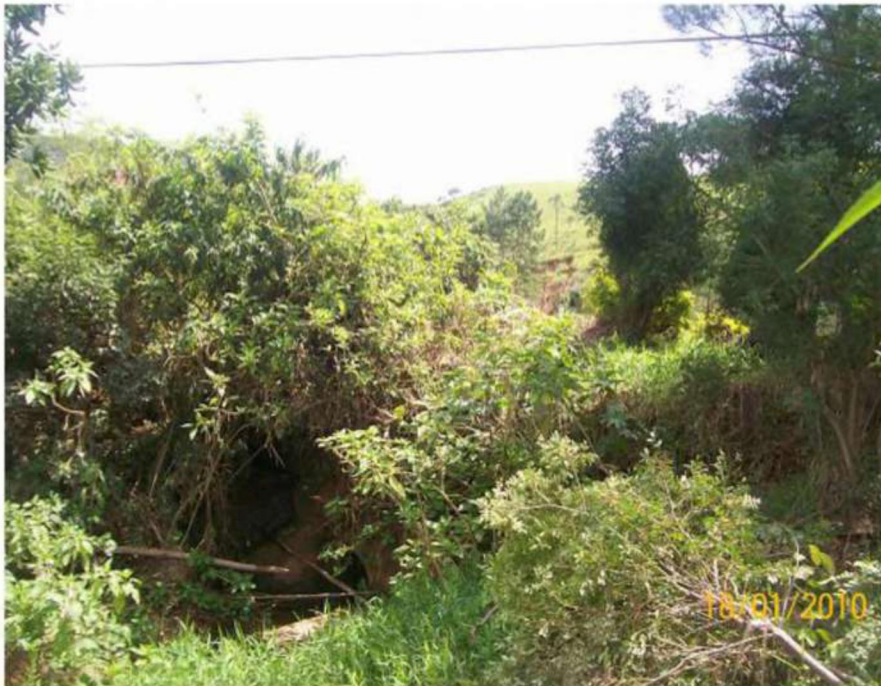
Figura 46 – passagem em linha de tubos sob o trevo da Estrada Ivo Senne
